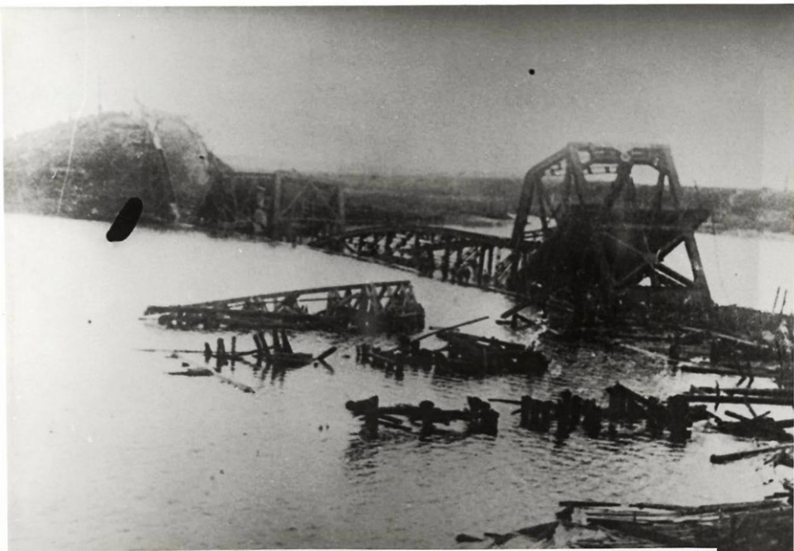
ВИД МОСТА ЧЕРЕЗ Р.СОЖ В ГОМЕЛЕ, ВЗОРВАННОГО НЕМЦАМИ ПРИ ОТСТУПЛЕНИИ 1943г.
