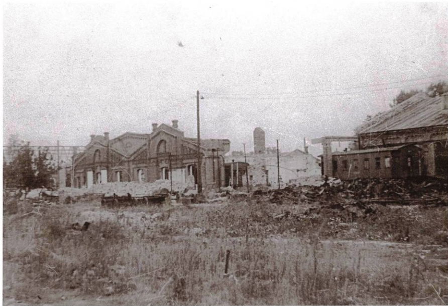
РАЗРУШЕННЫЕ КОРПУСА ПАРОВОЗОВАГОНРЕМОНТНОГО ЗАВОДА 1944 г.
