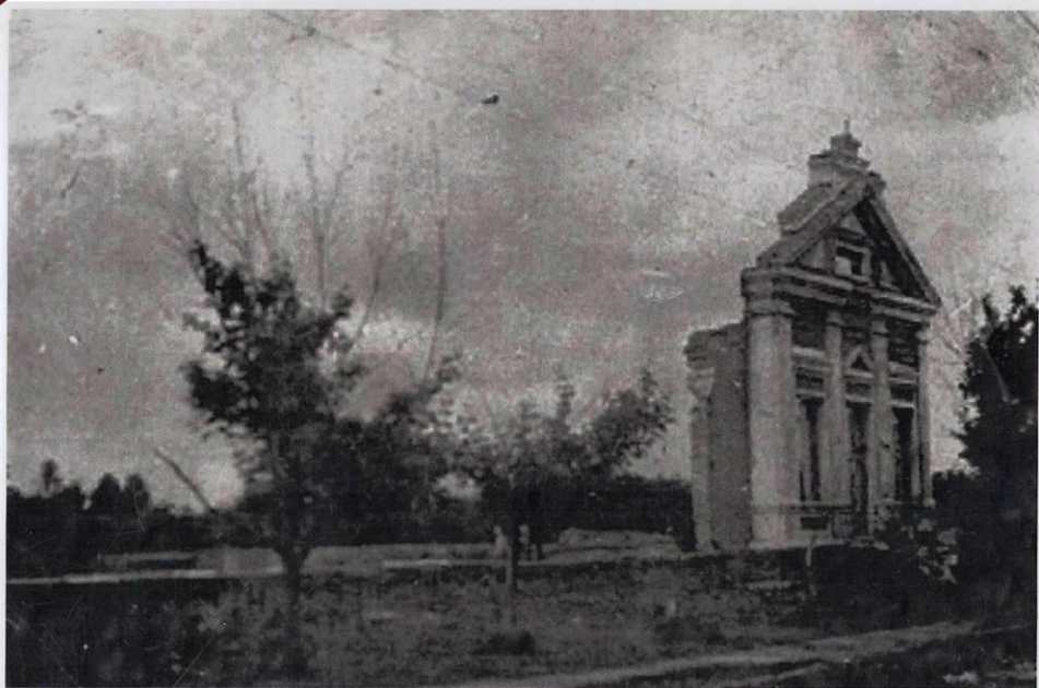
Разрушенное здание средней школы по ул. Котовского. 1943 г.
